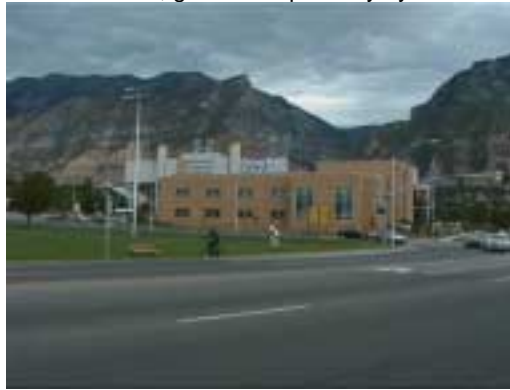
On the left of the intersection stands our block above A la izquierda del cruce está nuestro edificio, arriba
